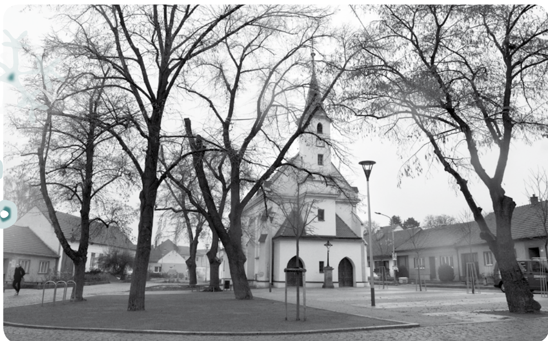
Park U Kaple těsně před dokončením
