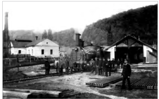
Strojní stanice s točnou pro lokomotivy postavená v roce 1895. Zastávka u Brna, dříve Boží požehnání, něm. Segen Gottes.
