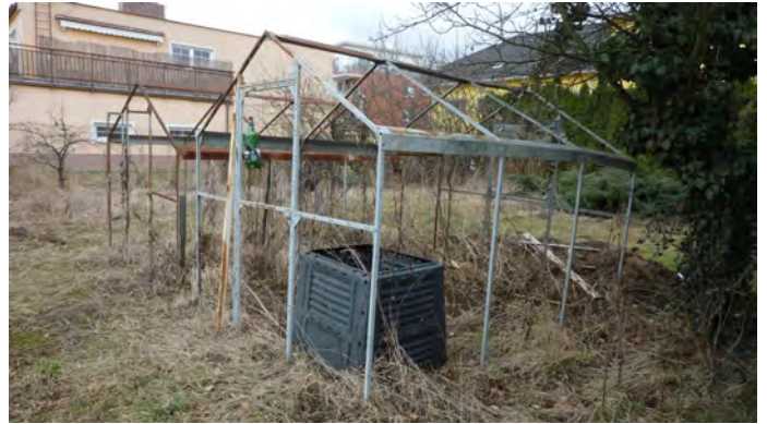
Pohled na konstrukce skleníku, které budou asanovány
